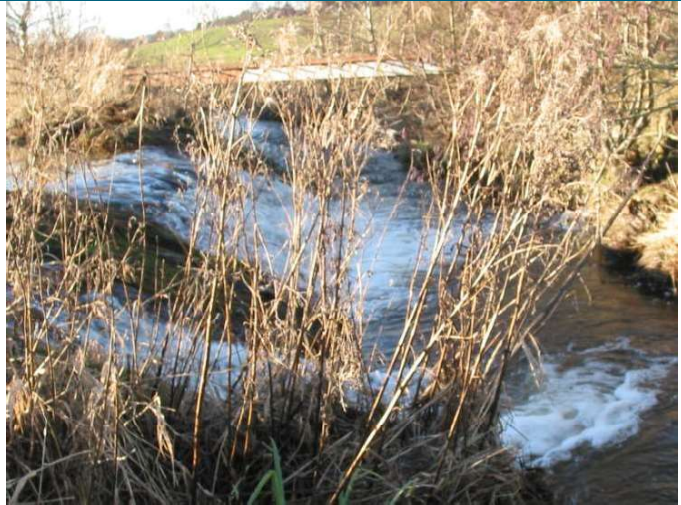
Figur 2: Foto af den nuværende overfaldskant mellem Hover å og det eksisterende omløbsstryg. Fotoet viser nedstrøms retning.
