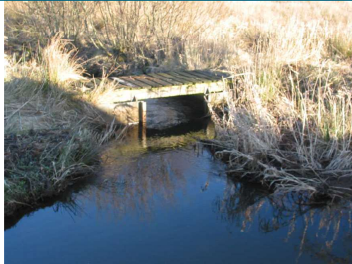
Figur 1: Indløb til det eksisterende omløbsstryg, der er placeret på modsat side af dambrugets nuværende vandindtag.
