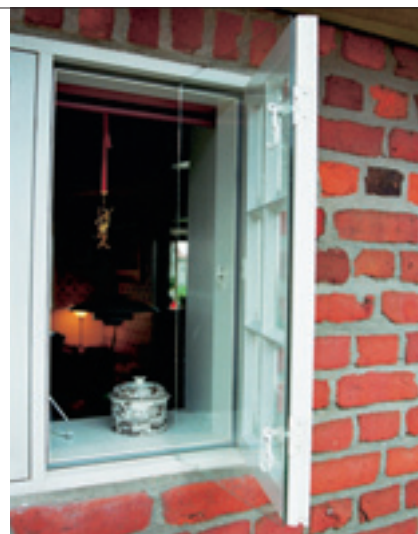
Nye vinduer fremstillet efter traditionelle principper med tynde sprosser og kitfals og med en koblet ramme, der sikrer en god isolering.
