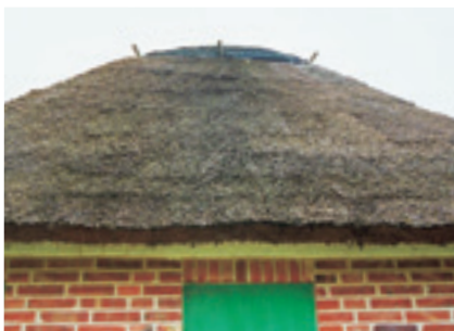
Enkelte steder bruger man stadig den gamle tradition med træpløkker til at fastholde mønningstørvene.
