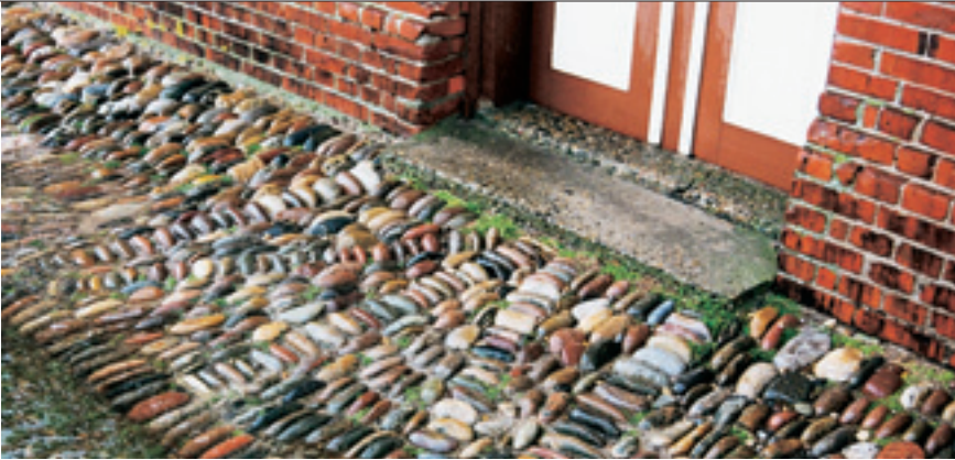
Typisk vestjysk pikstensbelægning, der med et skråt fald væk leder vand væk fra soklen og modvirker opfugtning af murværket. Foto Peter Duun.
