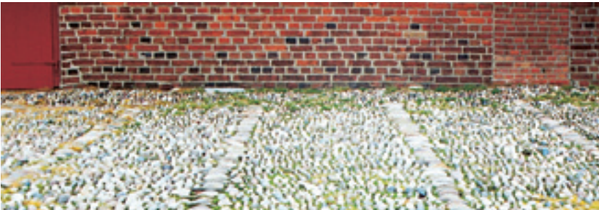
På gårdspladsen er belægningen ofte opdelt af regelmæssige fagstriber, hvor stenene ligger i anden retning end de øvrige eller har en anden størrelse.
