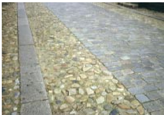
Et eksempel på naturstensbelægning i en af Ringkøbings gader. Pigsten, bordursten og brosten.
