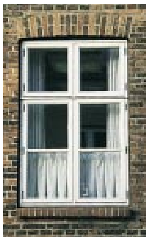
Fire-rammet klassicistisk vindue i Algade.
